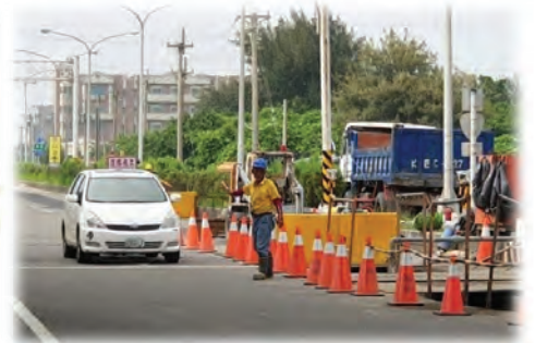
分段施工並派員疏導交通
