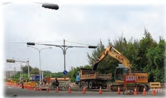
運土車停放於挖土機旁
