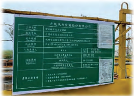
施工路段明確標示施工期程
