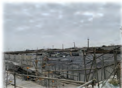
工區裸土加以覆蓋
