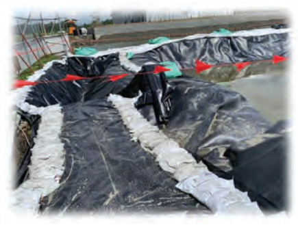
設置HDD擴管出土收集坑
