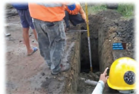
開挖期間施工監看
