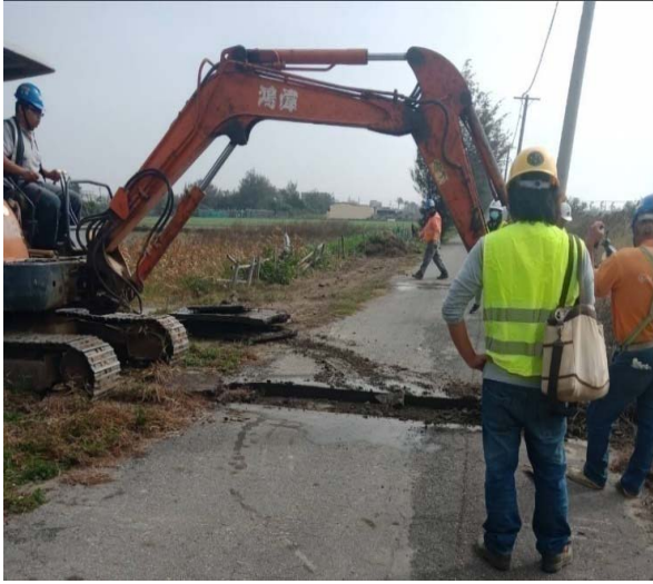
開挖期間委請考古人員監看
