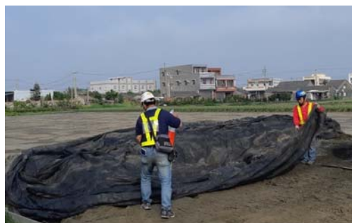
儲料、堆土區加以覆蓋
